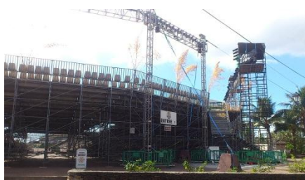
ダンスを盛り上げる照明設備
